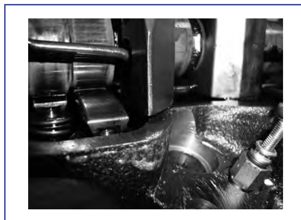
Assentamento incorreto (folga excessiva)
